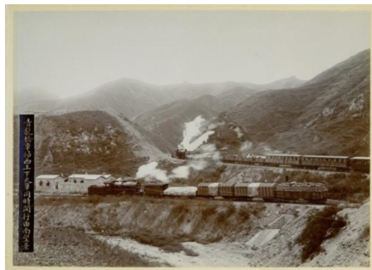
《青龙桥车站西上下火车同时开行由南望景》，著名的人字形铁路
