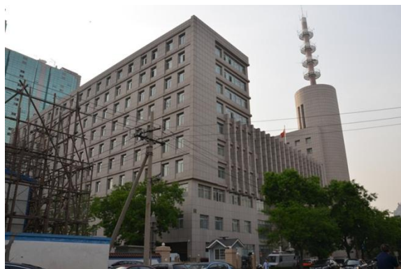
图 9: 弘明府邸今址上的北京消防指挥中心大楼
