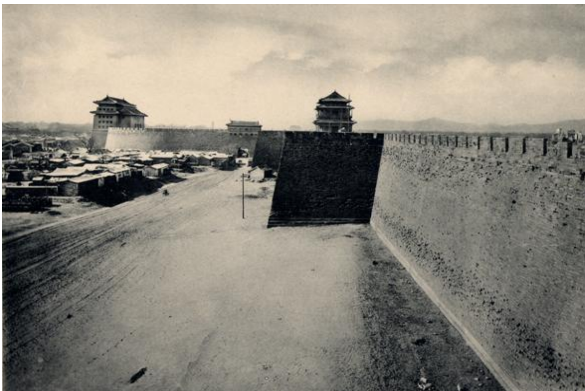
图 1：宣武门箭楼、瓮城、闸楼、城楼和城墙。东闸楼下券门前宽阔的土路通往正阳门（由西向东）
