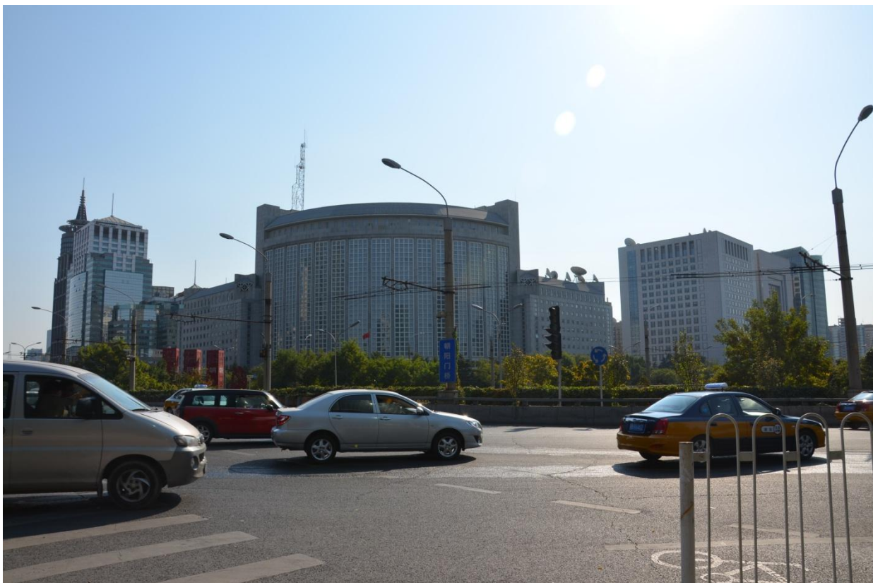
图 17：2013 年 10 月 24 日早间拍摄的朝阳门桥
