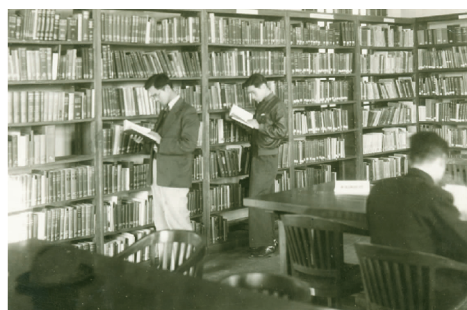
1947年文津街馆工程阅览室
