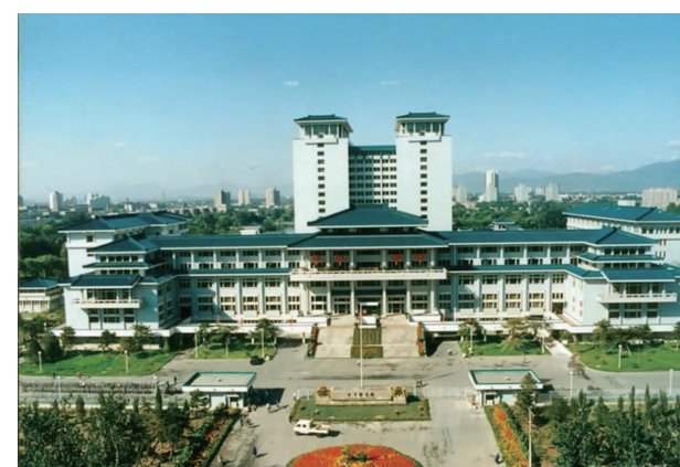
20世纪80年代白石桥新馆正面全景
