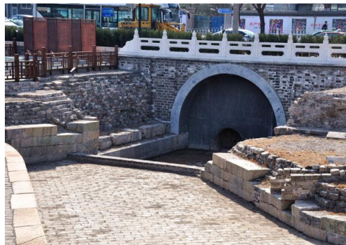
图5 玉河遗址公园的东步梁桥遗址(北侧)
