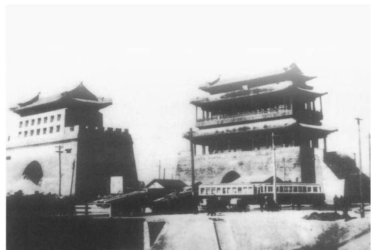
图4：1951年永定门瓮城东西两侧城墙被拆除
